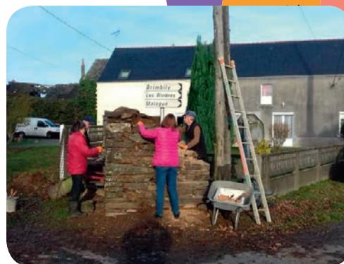
Restauration du puit route de Malague
